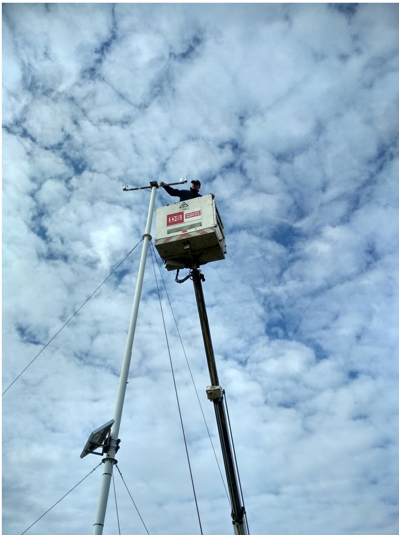
Εικόνα 1.2-2: Απο τις τεχνικές εργασίες στον σταθμό KTL-1 στις 22/12/2021.
