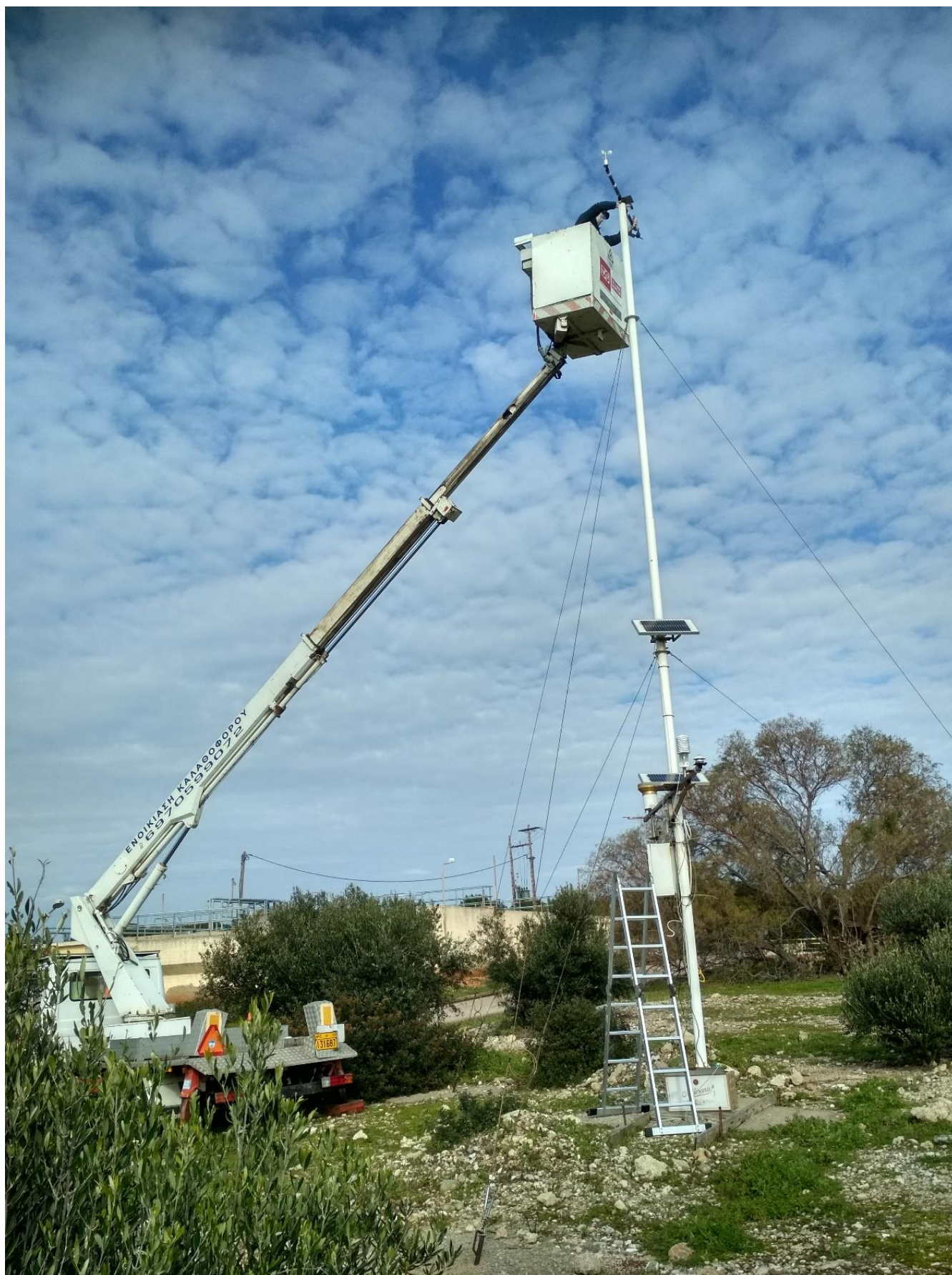
Εικόνα 1.2-1: Απο τις τεχνικές εργασίες στον σταθμό KTL-1 στις 22/12/2021.
