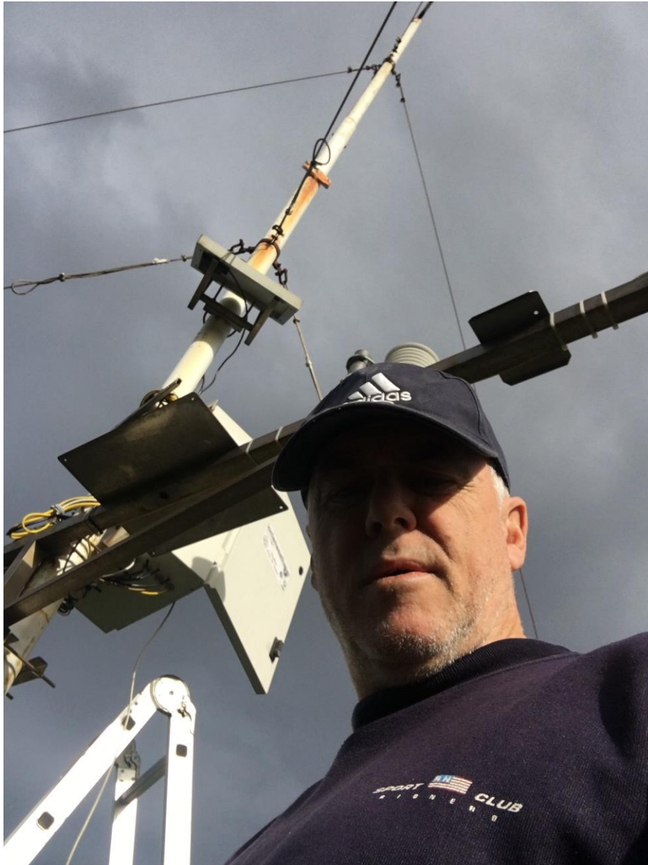
Εικόνα 1.2-8: Απο τα τεχνικά έργα στον σταθμό ZKT-3 στις 26/12/2021.
